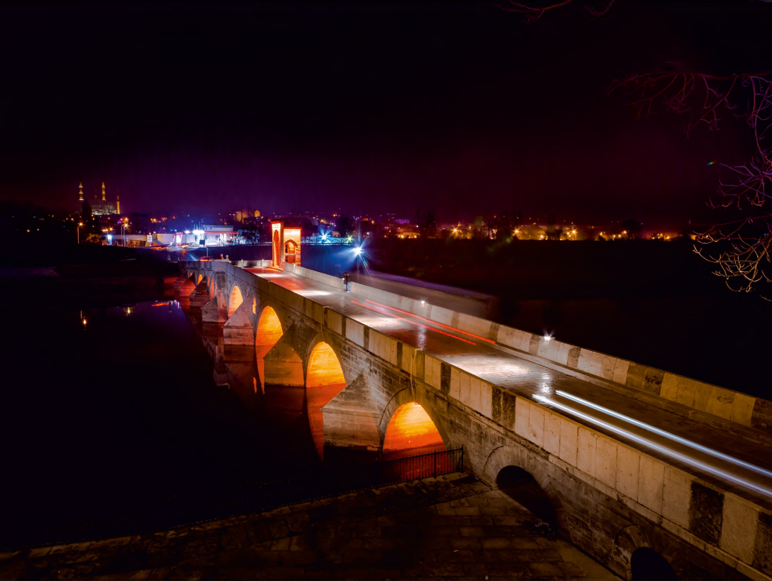
Meriç Köprüsü Мостът Марица Meriç Bridge
