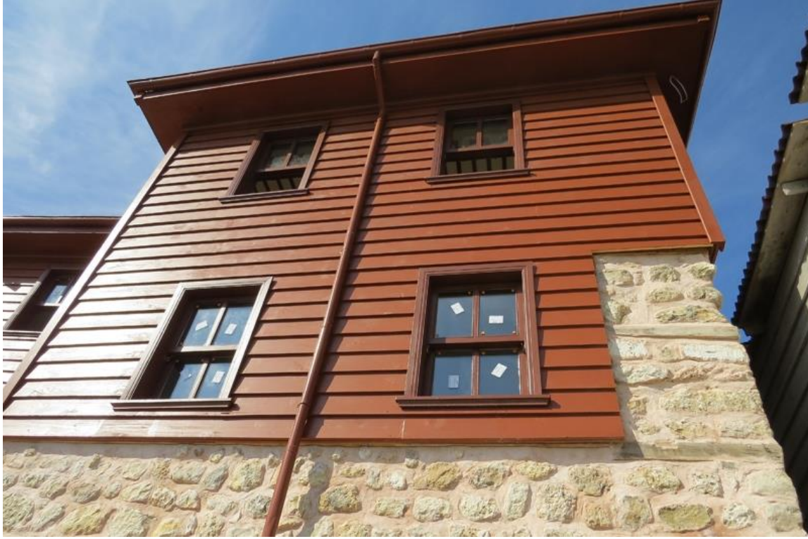
Fotoğraf 11: Kıyıköy Eski Ptt binasından görünüm
