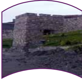
Kale Duvarı, Sozopol
